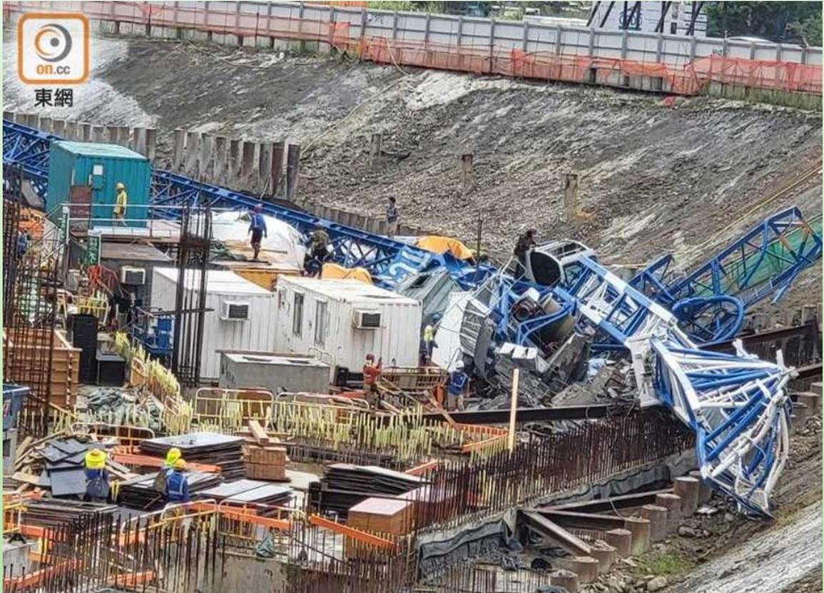
秀茂坪今日(7日)發生嚴重工業意外，安達臣道地盤內一個操作中的天秤，懷疑底部未有妥善固定，「秤腳」突然從其中一邊的工字鐵鬆脫，造成整個天秤傾斜塌下，擊中底下多個貨櫃辦公室。事故共造成3死6傷，包括一名被困多時的工人，他至事發約7小時後才被救出，惜已返魂乏術。行政長官李家超已就意外作出指示，要求勞工處全面檢視全港的天秤安全；勞工及福利局局長孫玉菡則指出，初步調查顯示事故涉及天秤基座問題，已向地盤發出暫時停工通知書，而房協亦會向死傷者親屬發放撫恤金及援助金，助他們解決燃眉之急。
